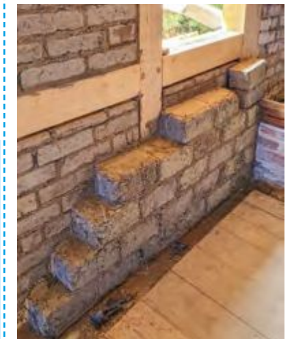
Sanierung einer Fachwerkwand mit Lehmziegeln
