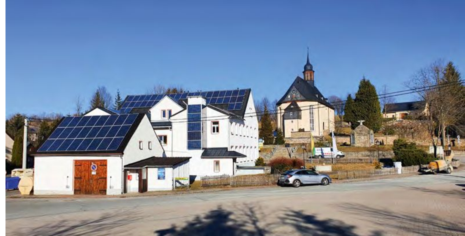
Mit PV-Modulen auf Dach und Fassade technisch geprägte Gebäudegruppe unmittelbar vor Kirche und Friedhof stören das Erscheinungsbild in einem Dorf.
