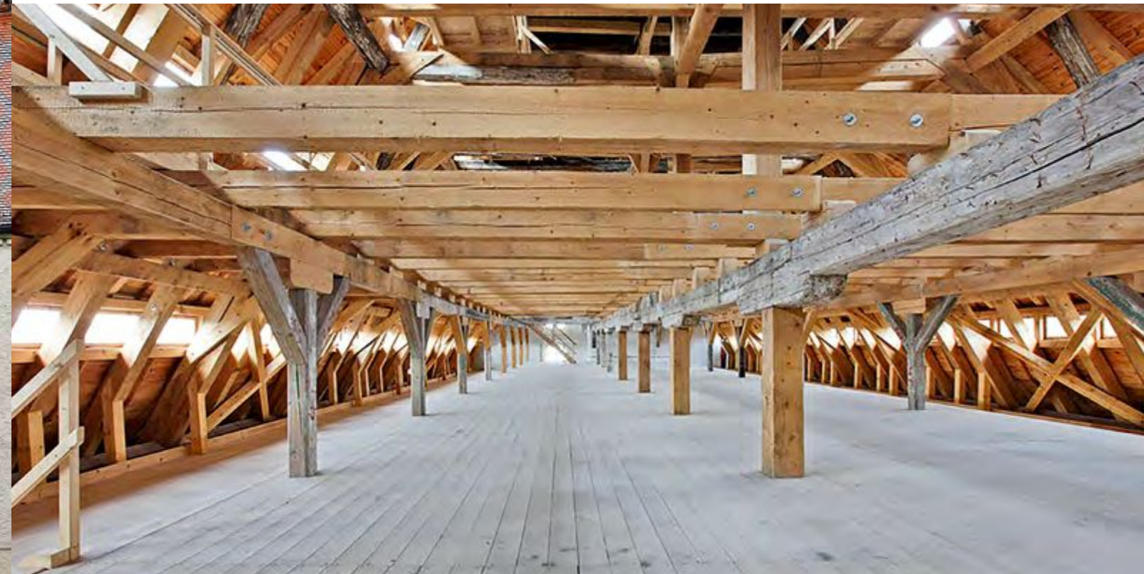
Zwickau, Niederes Kornhaus, Blick in den historischen Dachstuhl
