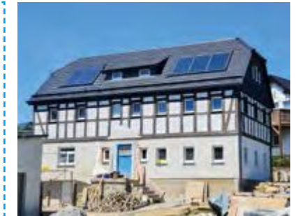
Dachintegrierte Solarthermieanlage mit Flachkollektoren
