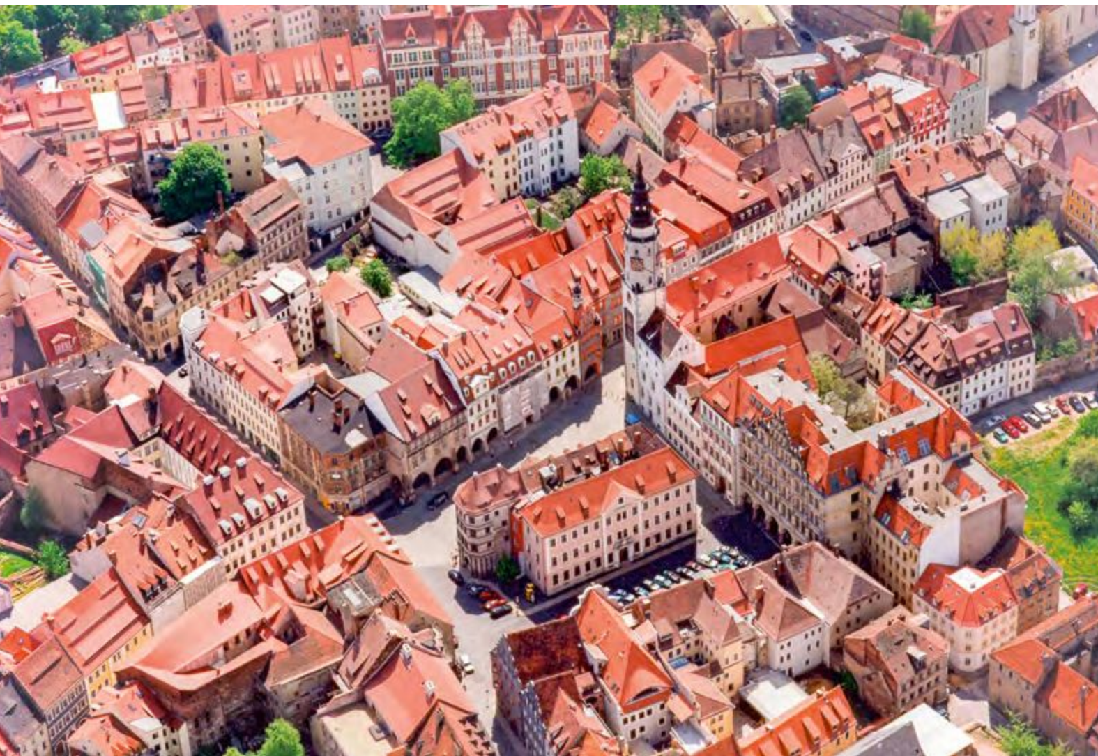
Görlitz, Altstadt von Nordost mit weitgehend sanierter Dachlandschaft in Ziegeldeckung
