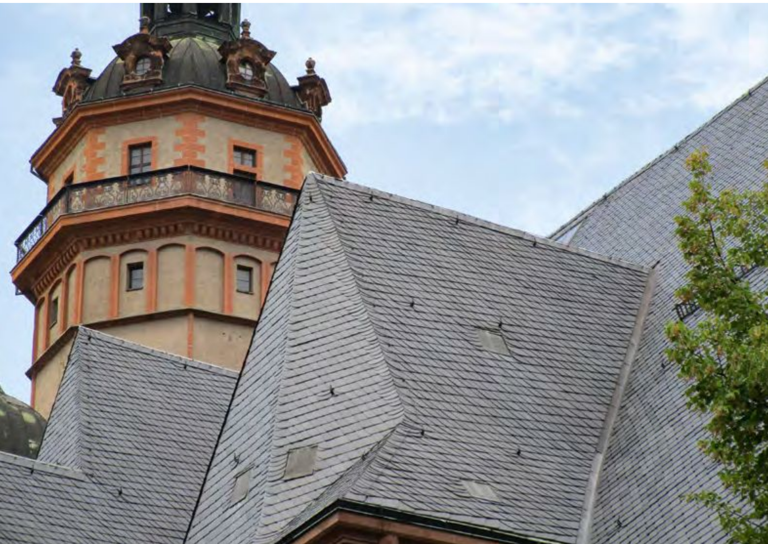
PV-Anlage auf dem Dach der Nikolaikirche in Leipzig, vom Straßenraum kaum erkennbare technische Lösung
