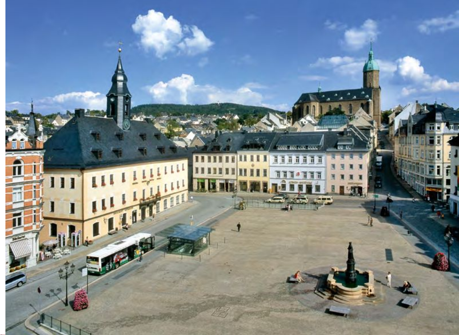
Annaberg, Blick über den Marktplatz zur Annenkirche mit kleinteiliger Dachlandschaft aus Schiefer. Die Installation von Solaranlagen ist hier besonders sensibel.
