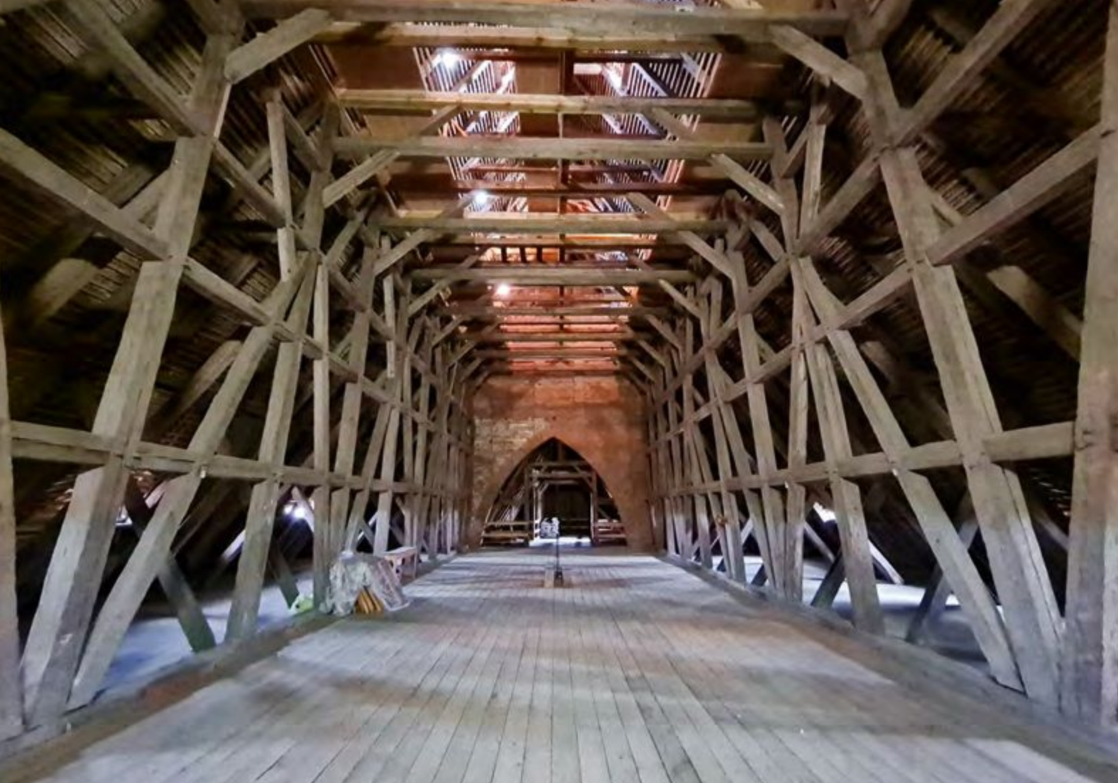
Dommitzsch, mittelalterliches Dachwerk der Kirche. Aus statischen Gründen und unter Aspekten des Brandschutzes ist die Installation einer PV-Anlage problematisch.
