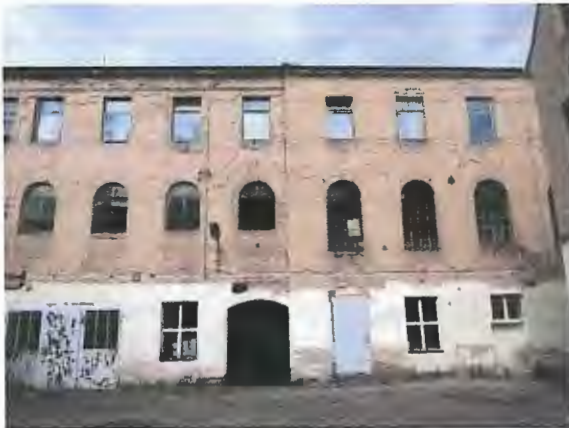
5a, Hofansicht / Ostfassade
