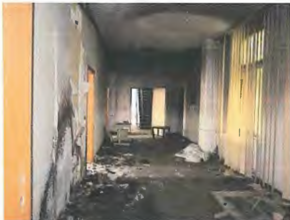
Innenraum Gebäude 1a 1. Obergeschoß
