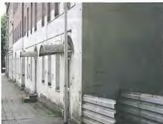
Zugang Haus 1a
