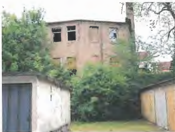
Westfassade, Ansicht vom Mühlweg
