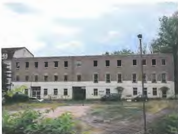
Gesamtansicht von Norden / Höroidstraße
