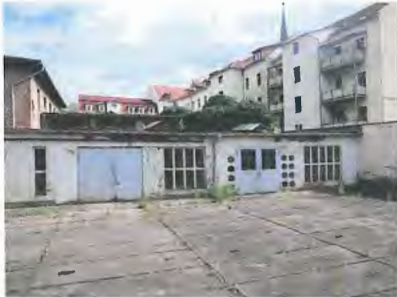
Hofffläche H2, Südansicht Gebäude 3c
