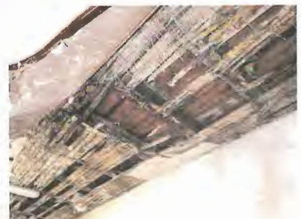
Feuchteschäden in der Deckenkonstruktion im Westteil
