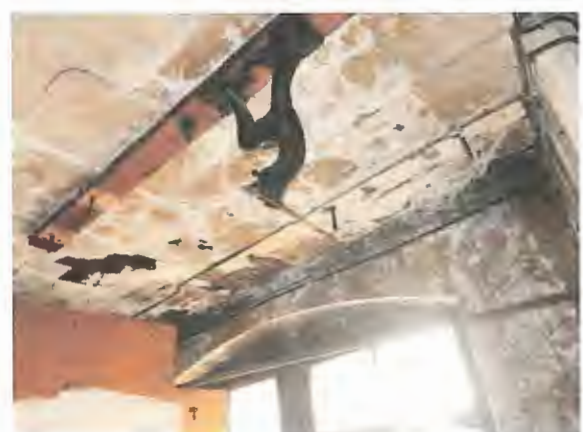
Feuchteschäden in der Deckenkonstruktion im Westteil
