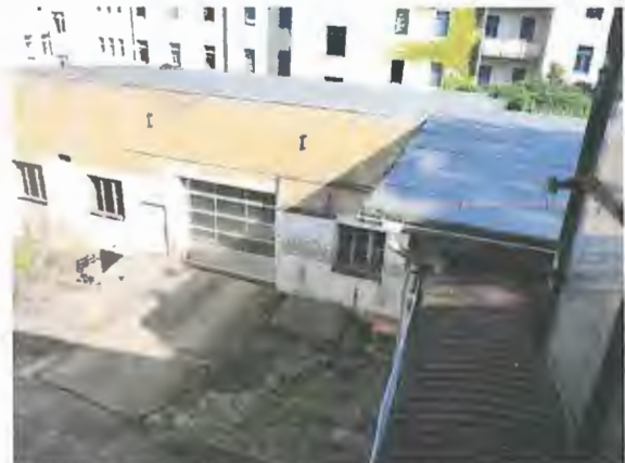
Westansicht Gebäude 3a und Hofffläche H1
