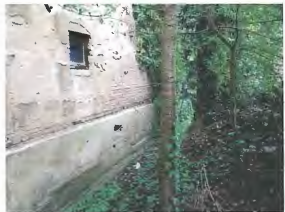
Westfassade, Sockelmauerwerk zum Mühlgraben
