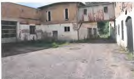
Hoffläche H1 mit Gebäude 3a, 4 und 5
