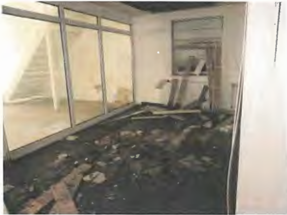
Gebäude 1b, EG, , ehem. Empfangsbereich der KFZ-Werkstatt
